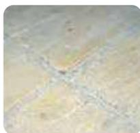
**5** Juntas de partición: para grandes superficies, es recomendable realizarlas cada 25 m<sup>2</sup>. El ancho de la junta debe ser de 6 mm, como mínimo, y debe rellenarse con un mástico, tipo **weber FLEX P100**.
