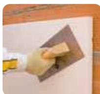
4 Colocar la placa de forma inmediata, presionando contra el soporte y ajustando los contornos y la planimetría con las placas adyacentes. Si las holguras en las juntas son superiores a 5 mm, rellenar con lascas de la propia placa aislante, para evitar puentes térmicos. Lijar los desniveles y retirar los residuos resultantes.
