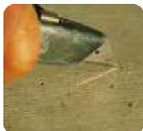
1 Comprobar la consistencia del soporte mediante medios mecánicos tales como un dinamómetro, para calcular la resistencia superficial a tracción del soporte (en los casos más exigentes) o, simplemente, rayando el suelo para comprobar la facilidad de penetración.
