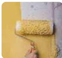
5 Sobre soportes lisos y no absorbentes (por ej. hormigón liso), aplicar la imprimación, que actúa como puente de adherencia.
