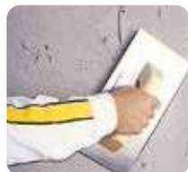
1 Los soportes deben ser planos, estar exentos de irregularidades y defectos de planimetría. De no ser así, la superficie debe regularizarse previamente mediante **webertherm BASEGEL** (pág. 131) o **webercal BASIC** (pág. 155).
