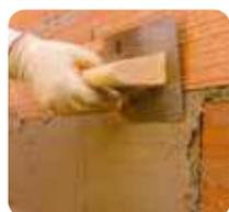
2 La parte inferior del muro (50 cm aprox.) debe impermeabilizarse con **weberdry IMPERFLEXGEL** (pág. 201), para impedir que la humedad proveniente del exterior penetre en el sistema.
