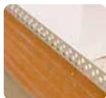
1 Empezar a colocar las placas desde la parte inferior, partiendo de **webertherm perfil arranque** y apoyando una hilada sobre otra, dispuestas con juntas desencontradas, tanto en las zonas frontales como en las esquinas.
