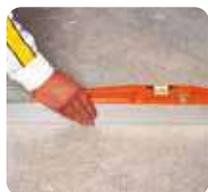
1 Verificar la planeidad y regularidad del soporte, ya que de ello depende el espesor del mortero de nivelación.
