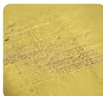
6 La pintura se considera bien adherida si el 80% de esa superficie está bien anclada al soporte. Si no fuera así, eliminarla mediante raspado o decapante.
