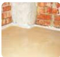
**4** Juntas perimetrales: la junta puede hacerse con un material elástico (ej: **weber FLEX P100** o pórex). El zócalo protegerá posteriormente esta junta. Éstas serán necesarias para superficies superiores a 12 m<sup>2</sup>.
