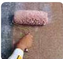
4 Sobre soportes no porosos y de baja absorción (cerámica, pintura, hormigón liso) o madera, aplicar la imprimación **weberprim FX15** (pág. 234).
