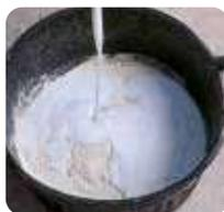
4 Sobre antiguas mamposterías de piedra y/o ladrillo para revestir, aditar la primera capa del mortero de revestimiento con una mezcla de agua y **weberprim TP05** (pág. 235) (relación 6:1).
