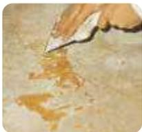
2 Eliminar los restos de colas al menos en un 90% de la superficie. Sobre residuos de colas bituminosas o epoxis, aplicar **weberprim EP 2K** (pág. 236) o **weberprim TP05**, según la porosidad del soporte.
