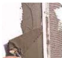
2 Las juntas de dilatación deberán respetarse interrumpiendo el sistema y utilizando **webertherm perfil junta dilatación** (pág. 144) aplicado sobre las placas de aislamiento.
