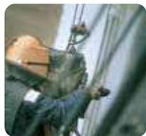
**2** Decapado abrasivo: chorroar con arena en seco o en húmedo.
