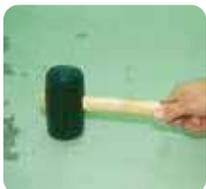
2 Verificar la adherencia de antiguos pavimentos mediante sondeo, con un martillo o una espátula.
