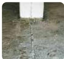
1 Los soportes a base de cemento deben ser de absorción normal para evitar la aparición de burbujas y secados prematuros.
