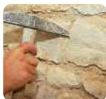
**2** Vaciar las juntas en una profundidad de 2 a 5 cm.
