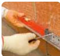
3 Delimitar el contorno inferior con **webertherm perfil arranque** (pág. 142) de anchura adaptada al espesor de las placas. Fijar los perfiles a unos 15 cm del suelo con tornillos y tacos adecuados cada 30 cm, dejando entre ellos 2-3 mm de espacio.
