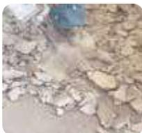
4 Si el soporte no es lo suficientemente duro, eliminarlo hasta encontrar un soporte sano, duro y consistente.
