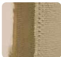
1 Reforzar las aristas del sistema en esquinas y contornos con **webertherm perfil esquinero** (pág. 143). El perfil será colocado directamente sobre la placa de aislamiento con el mismo mortero polimérico.
