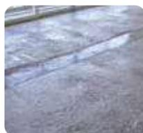
3 Una vez seca la primera mano, se repetirá el proceso 2 o 3 veces más hasta obtener una superficie dura y sólida. El número de aplicaciones dependerá del estado original del soporte y de su grado de debilitamiento.
