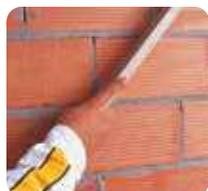
1 Verificar con un regle los defectos de planeidad en soportes nuevos, para evitar los gruesos excesivos del material en una sola aplicación.
