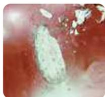
2 ... se ocasionarán fallos de adherencia y fisuras en el revestimiento de acabado.
