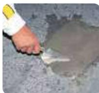
2 Si existen coqueas u oquedades, éstas se deben rellenar con el mortero de reparación de fraguado rápido, **weberfloor 4045** (pág. 196). Tras 4 horas de secado, la superficie ya es apta para la colocación del mortero autonivelante.
