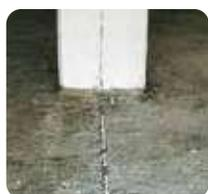
**3** Juntas estructurales: es necesario rellenarlas con materiales de elasticidad permanente, como el sellador elástico **weber FLEX P100** (pág. 233). Respetar también la junta en el revestimiento a colocar.
