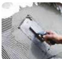
3 Previo a la capa de regularización, reforzar zonas como cantos de huecos en puertas y ventanas, con **webertherm malla 160** (pág. 135) directamente sobre las placas de aislamiento, utilizando **webertherm BASEGEL** (pág. 131).
