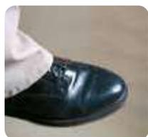
2 La aplicación de una capa de mortero nivelador sobre otra, debe realizarse tan pronto como la primera capa pueda pisarse.
