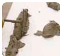
2 Sobre soportes de albañilería o mampostería, aplicar un cordón de **webertherm BASEGEL** de 4-8 cm de ancho y 2-4 cm de espesor, en el perímetro de la placa, y tres pegotes de 8-10 cm de diámetro en el centro. La superficie de contacto una vez colocada la placa, debe ser de un 40%, como mínimo.
