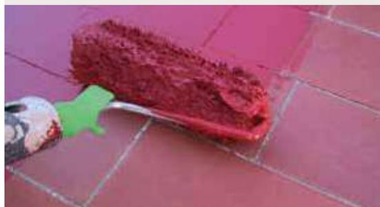
Membrana líquida acrílica altamente reforzada para la impermeabilización de cubiertas y tejados visitables
