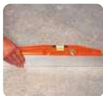
**1** Verificar la planeidad y regularidad de la superficie del soporte, ya que de ello depende el espesor del mortero de nivelación.
