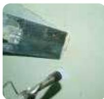
**3** Decapado en caliente: calentar suficientemente el revestimiento para reblandecerlo, sin llegar a quemarlo. Rascarlo mediante un útil caliente...
