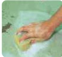
3 Eliminar barnices y ceras mediante raspado o lijado. Más tarde limpiar detenidamente y aplicar la imprimación **weberprim FX15** o **weberprim TP05**, según la porosidad del soporte.
