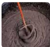
1 El amasado debe realizarse con agua limpia. La mezcla debe ser fluida y homogénea.
