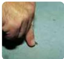
2 Verificar la dureza del soporte, rayando la superficie con un clavo o destornillador. Para que el soporte sea duro, la rayadura realizada debe ser únicamente superficial.
