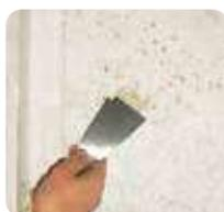
**6** Las pinturas rugosas o revestimientos sintéticos gruesos, se deben retirar completamente con los medios adecuados (decapado químico, decapado en caliente o decapado mecánico) si presentan falta de adherencia.
