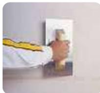
3 Aplicar una capa de revestimiento, apretando y pasando la llana varias veces, para dejar el espesor de la capa.
