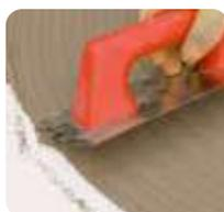
3 Sobre superficies previamente regularizadas con **webercal BASIC** o con muy buena planimetría, **webertherm BASEGEL** puede aplicarse en toda la superficie de la placa con llana dentada (doble encolado).
