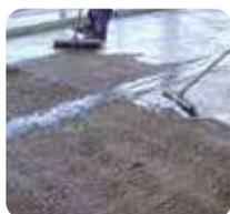
2 La resina consolidante **weberprim TP05** posee un alto poder de penetración en el poro y, juntamente con la dilución en agua, nos ayudará a consolidar los primeros milímetros del soporte. En soportes horizontales se podrá aplicar mediante cepillado o pulverización, siendo este último método el más adecuado para soportes verticales.
