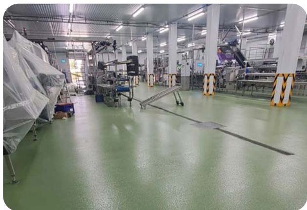
Multicapa weberfloor PURLEVEL 2C y DECOPUR 1C | Industria
