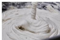
Amasar **webercol flex<sup>3</sup> superapid** con la cantidad de agua limpia indicada en la tabla final, por saco de 25 kg, con un batidor eléctrico lento (500 rpm) hasta obtener una masa homogénea y exenta de grumos.
