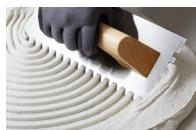
Extender sobre el soporte en paños pequeños y peinar con una llana dentada###HARD\_RETURN### de 8x8 mm para regularizar el espesor de la aplicación.
