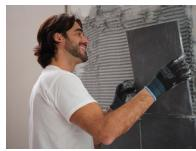
Colocar las baldosas y presionarlas hasta conseguir el aplastamiento de los###HARD\_RETURN###surcos del mortero cola. Comprobar periódicamente la pegajosidad de la pasta###HARD\_RETURN###levantando la baldosa previamente colocada.
