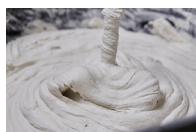
Amasar **webercol dur** con la cantidad de agua limpia indicada en la tabla final, por saco de 25 kg, con un batidor eléctrico lento (500 rpm) hasta obtener una masa homogénea y exenta de grumos. Dejar reposar la mezcla unos 2 minutos y realizar un ligero reamasado.
