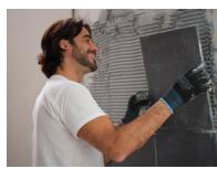
Colocar las baldosas presionándolas hasta conseguir el aplastamiento de los surcos del mortero cola y un buen macizado de la pieza. Comprobar periódicamente la pegajosidad de la pasta levantando la baldosa previamente colocada. Es aconsejable dejar juntas entre piezas colocando crucetas de 2 mm como mínimo en interiores y 5 mm en exteriores, rellenándolas con###HARD\_RETURN###morteros de rejuntado de la **gama webercolor**.
