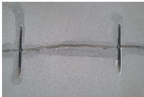
Figura 5.1: Instalación de varillas para el tratamiento de fisuras de gran espesor previas del soporte.
