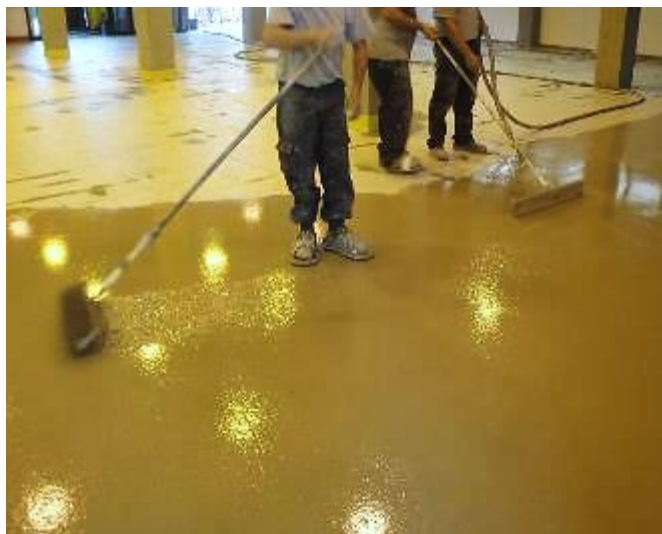
Figura 5.2: Vertido y tratamiento del mortero polimérico autonivelante.
