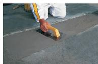
Aplicar la mezcla con una espátula y con un espesor máximo de 2 mm por capa. Pasadas 4 horas y una vez haya endurecido la primera capa, aplicar la segunda mano de producto.
