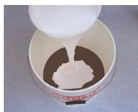
Verter el contenido de la garrafa (componente B) en un recipiente limpio y añadir el contenido del saco de polvo (componente A) mientras vamos removiendo la mezcla.
