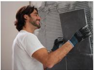
Colocar las baldosas y presionarlas hasta conseguir el aplastamiento de los surcos del mortero cola. Comprobar periódicamente la pegajosidad de la pasta levantando la baldosa previamente colocada.
