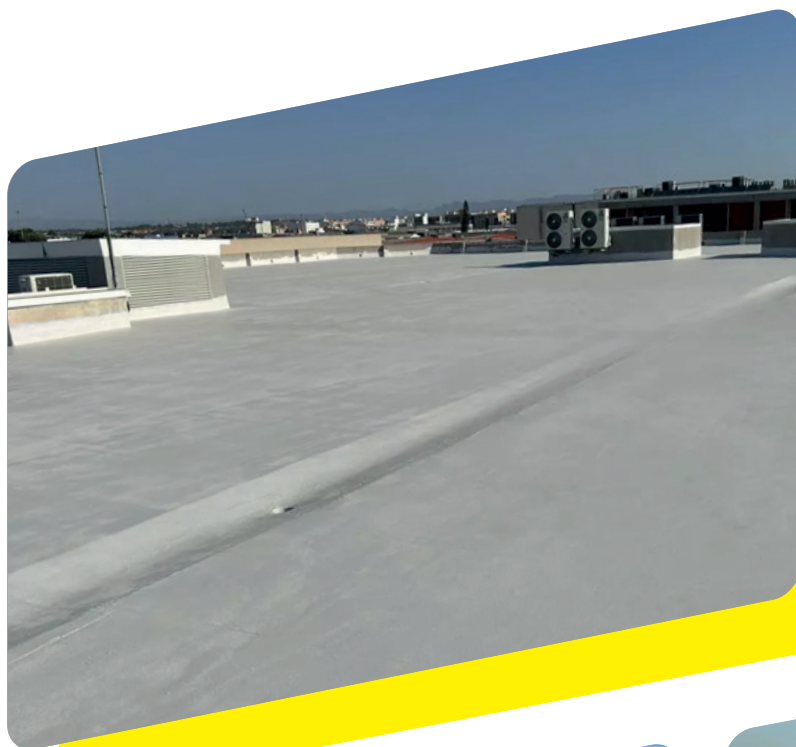
Pavimento de impermeabilización reforzado de 6.500 m 2
