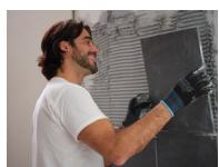
Colocar las baldosas y presionarlas hasta conseguir el aplastamiento de los surcos del mortero cola. Comprobar periódicamente la pegajosidad de la pasta levantando la baldosa previamente colocada.
