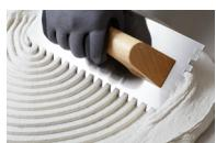
Extender sobre el soporte en paños pequeños y peinar con una llana dentada de 8x8 mm para regularizar el espesor de la aplicación.
