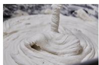
Amasar\* webercol flex2 multirapid con la cantidad de agua limpia indicada en la tabla final, por saco de 25 kg, con un batidor eléctrico lento (500 rpm) hasta obtener una masa homogénea y exenta de grumos.
