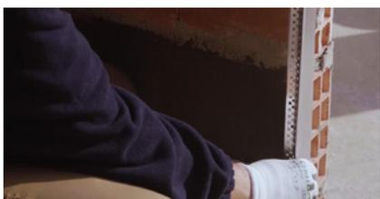
Por otro lado y si es necesario, colocar otros perfiles de remate del sistema como pueden ser **webertherm perfil coronación** y **webertherm perfil lateral**.
