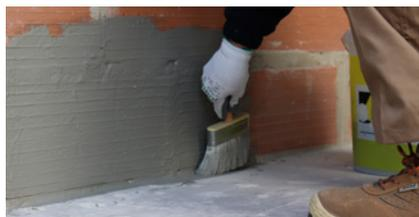
Aplicar **weberdry imperflex** o **weberdry imperflex 2C** con brocha o llana de acero inoxidable, cubriendo en forma de "L" el encuentro el plano horizontal y vertical del zócalo, hasta la altura prevista para la colocación del perfil de arranque.
