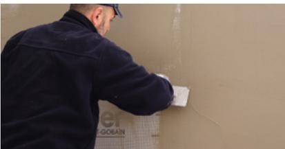
Pasar una llana de acero inoxidable de "ala ancha" con el objetivo de alisar el peinado y conseguir un espesor homogéneo del mortero (2-3 mm). No presionar en exceso con la llana metálica, ya que se desplazaría la malla hacia el interior de la capa del mortero. Es muy importante que la webertherm malla se quede en la superficie de esta primera capa.
