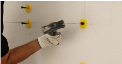
Colocar la espiga en el orificio y, en función del tipo de espiga elegido, realizar el atornillado o golpeo de la misma.
