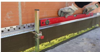
Con la ayuda de un nivel y soportes de regla, marcar la posición del perfil de arranque.
