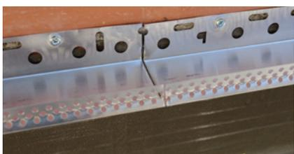
Dejar una separación de 2-3 mm entre perfil y perfil para permitir la dilatación.
