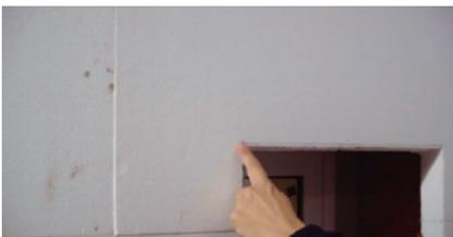
En los vértices de los huecos de fachada (como ventanas, puertas, etc.), colocar las placas aislantes en forma de "L" de forma que queden envueltos por la misma, evitando el alineamiento de los bordes del hueco con los de la placa, tanto en horizontal como en vertical. La disposición de las placas de este modo, contribuirá a disminuir el riesgo de aparición de fisuras a 45° en estos puntos. (Detalle 3b)
