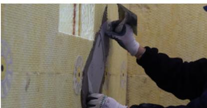
En los vértices de los huecos, existe riesgo de aparición de fisuras a 45° en el revestimiento, que pueden minimizarse con el uso de una malla de fibra de vidrio dispuesta en la misma dirección que la tensión que las provoca. Colocar tiras de malla de fibra de vidrio de tamaño mínimo de 20x40 cm o **webertherm malla vértices**.
