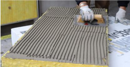
Cuando el soporte sea suficientemente plano (hormigón, enlucado, placa Glasroc X, placa de madera...), aplicar el mortero sobre el reverso de la placa y repartirlo por toda la superficie con una llana dentada de 8-10 mm, realizando un peinado en el sentido longitudinal de la misma e inclinando la llana 45° respecto a la cara de la placa.
