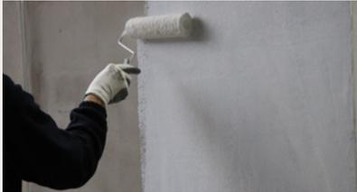
Aplicar la imprimación seleccionada en función del acabado y mortero de regularización (ver tabla), cubriendo la superficie en su totalidad.
