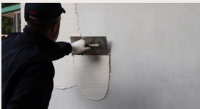
Pasadas 24 horas aproximadamente, y cuando la imprimación esté totalmente seca, aplicar el revestimiento seleccionada de la gama **webertene**. Estos productos vienen listo al uso y se pueden aplicar a llana o pistola, en función del acabado final deseado.
