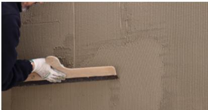
Aplicar una primera mano de espesor 2-3 mm del mortero de regularización (**webertherm base, webertherm base plus o webertherm flex B**) sobre la capa de aislamiento. Extender el mortero por toda la superficie, con una llana de acero inoxidable y realizar un peinado con una llana dentada de 6-8 mm inclinándola a 45° para controlar que la carga de material y el espesor sean los adecuados y homogéneos en toda la superficie.
