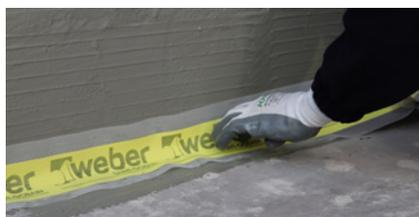
Con el mortero impermeabilizante aún en fresco, colocar la banda elástica **weberdry imperbanda** sobre el encuentro entre los dos planos, adaptándola al ángulo que éstos conforman.
