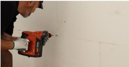
Realizar el taladro en el soporte con broca de diámetro de 8 mm sin percutor, para no deteriorarlo internamente.
