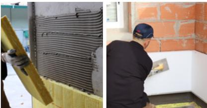
Inmediatamente después de la aplicación del adhesivo, colocar la placa en su posición final, presionando contra el soporte y realizando golpes secos con una llana de acero inoxidable en plano, para que el mortero de adhesión se extienda.
