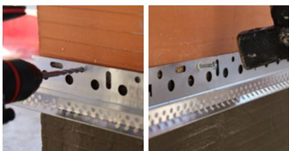
Fijar el perfil, **webertherm perfil arranque**, con tornillos de zinc y tacos adecuados al soporte, separados entre ellos 30 cm.
