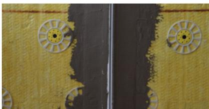
Las juntas de dilatación estructurales del edificio deben ser respetadas manteniendo la ruptura de la continuidad en el sistema SATE a instalar. Éstas requieren de algún elemento que permita una unión muy flexible, cuidada y estética (**webertherm perfil junta dilatación**).
