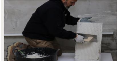
Aplicar el mortero cola **webercal flex<sup>®</sup> multirapid** o **webercal flex<sup>®</sup> superapid** (según formato de la pieza) mediante la técnica de doble encolado, con una llana dentada.
