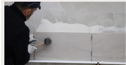
Colocar la pieza y apretar bien contra el soporte para repartir, homogéneamente, el mortero cola y aplastar los surcos de la llana dentada, asegurando el contacto en toda la superficie (mínimo 90%).
