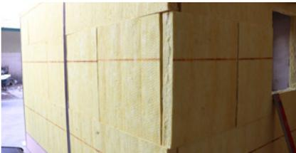
Realizar la disposición de las placas a rompe-juntas respecto a sus hileras adyacentes evitando la continuidad de las juntas.
