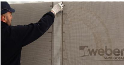
Colocar la malla de fibra de vidrio sobre los surcos generados por el peinado de esta primera capa de mortero dispuesta en posición vertical y solapando un tramo con el otro un mínimo de 10 cm.
