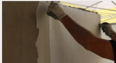
Colocar una malla de refuerzo de fibra de vidrio, **webertherm malla 65**, solapándola 2 cm en los encuentros entre malla y malla.
