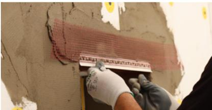
El dintel requiere del tratamiento de la arista mediante un elemento que permita la evacuación correcta del agua de lluvia y evitar así problemas de humedades que puedan derivar en una rápida degradación del revestimiento (**webertherm perfil goterón**).
