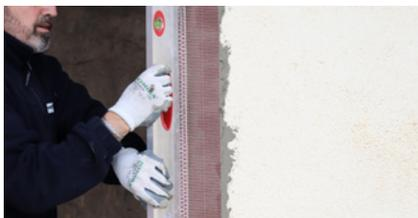
Las aristas o esquinas del edificio requieren de un refuerzo frente a posibles impactos y de una terminación recta y estética (**webertherm perfil esquinero**).
