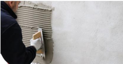
Del mismo modo, aplicar el mortero de adhesión sobre el soporte y realizar el peinado en horizontal con una llana dentada de 8-10 mm.
