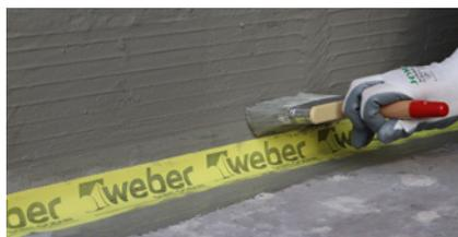
Aplicar una segunda capa de mortero impermeabilizante cementoso flexible sobre los laterales de la banda elástica formados por malla de polipropileno, cubriéndolos totalmente y dejando la parte central de la banda sin cubrir y suelta para que pueda absorber correctamente los movimientos.
