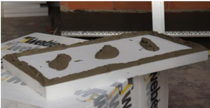
Sobre soportes de ladrillo, con pequeñas irregularidades o diferencias de planimetría pequeñas (menores de 1 cm en 2 m), aplicar el mortero de adhesión sobre el reverso de la placa formando un cordón perimetral de unos 5 cm de ancho y 3 cm de alto, y tres pegotes centrales, asegurando siempre una adhesión mínima del 40% de la superficie de la placa.
