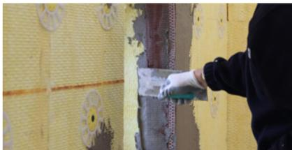
Colocar la parte de malla del elemento sobre el mortero, presionar con el paso de una llana de acero hasta que la malla quede totalmente anclada al mortero y dejar secar mínimo 24 horas<sup>(1)</sup> antes de la aplicación del refuerzo general del sistema (**apartado 5.2**).
