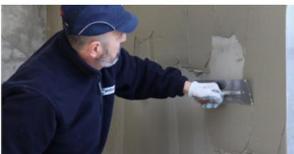
Una vez seca esta primera mano con malla, aplicar la segunda capa (2-3 mm) de mortero de regularización. Cuando ésta empiece a endurecer, fratar y dejar la superficie lista para ser revestida.
