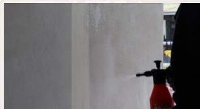
En caso de **webercal estuco**, una vez el revestimiento haya secado, aplicar el hidrofugante superficial **weberneto S400** sobre toda la superficie, preferiblemente mediante pulverizador.
