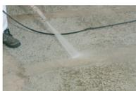
• El substrato deberá estar asentado, seco, libre de polvo, grasa y demás impurezas que pudieran dificultar la adhesión. Si es necesario, el substrato deberá ser tratado mecánicamente mediante abrasión mecánica tipo fresado, granallado o diamantado en función del soporte y posterior aspirado. • El soporte deberá tener una resistencia a la compresión mínima de 12 MPa y una resistencia a la tracción superior a 1,2 N/mm<sup>2</sup> (ensayo \*pull-off\*).
