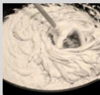
Amasar **weberco SUPERGEL premium** con 7,5 -8,5 litros de agua limpia por saco de 25 kg con un batidor eléctrico lento (500 rpm) hasta obtener una masa homogénea y exenta de grumos. Dejar reposar la mezcla unos 2 minutos y realizar un ligero reamasado.
