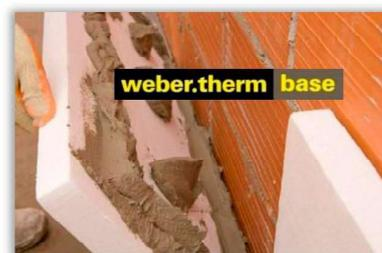
Las placas deben ser colocadas en posición horizontal en filas sucesivas, de abajo a arriba, a rompe-juntas en relación con la hilera anterior. Del mismo modo en las esquinas, los extremos de las placas deberán ser alternados, para mejorar el trabamamiento del sistema.
