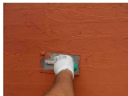
Si el acabado deseado contempla la realización de un ladrillo con acabado con diferentes tonalidades, sobre la primera mano de **weber.tene micro**, aplicar a pegotes el mismo producto pero con una tonalidad superior, y fratar con el paso de una llana en trazos horizontales, dejando una superficie irregular.
