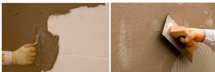
No aplicar nunca la malla directamente sobre el material aislante. En las juntas de la malla deberá existir una superposición mínima de 10 cm, y esta deberá envolver las aristas donde existan **weber.therm perfil esquinero PVC**.
