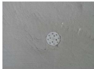
La **segunda capa**, destinada a regularizar y recibir el aplacado cerámico, debe garantizar la correcta cobertura de la malla y de las espigas de fijación. La malla y las espigas deben quedar cubiertas en la totalidad, y se deberá dejar una superficie plana, sin resaltos y con una textura constante en toda la superficie con el paso de la llana a 45° para abrir el poro cuando el material haya comenzado a endurecer.
