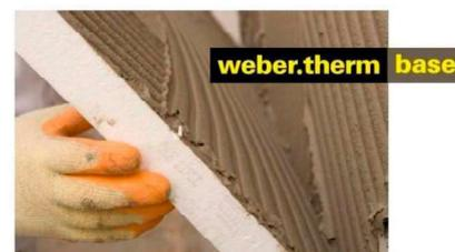
Sobre soportes planos, el mortero de adhesión se puede aplicar en toda la superficie de la placa, con una llana dentada (de dientes de 9-10 mm). Pudiendo ser necesario aplicar también mortero en el soporte, en caso que exista en éste alguna irregularidad que dificulte el contacto perfecto con la placa (comprobar la planimetría de las placas y que el mortero de adhesión de la placa está en contacto con el soporte en la totalidad de la superficie).
