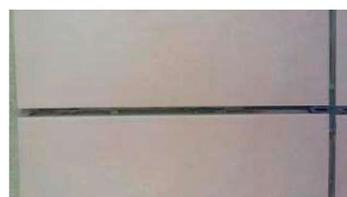
La superficie se rejuntará una vez hayan pasado un mínimo de 3 días desde la adhesión de las piezas cerámicas, y se realizará con el mortero de rejuntado **weber.color premium**; para dotar de una hidrofugacidad extra a la junta se puede aplicación posteriormente de un hidrofugante en base agua. Prever juntas de dilatación entre piezas cerámicas con un ancho mínimo de 8 mm, que serán rellenas con el mortero de rejuntado definido en el punto 4.6.
