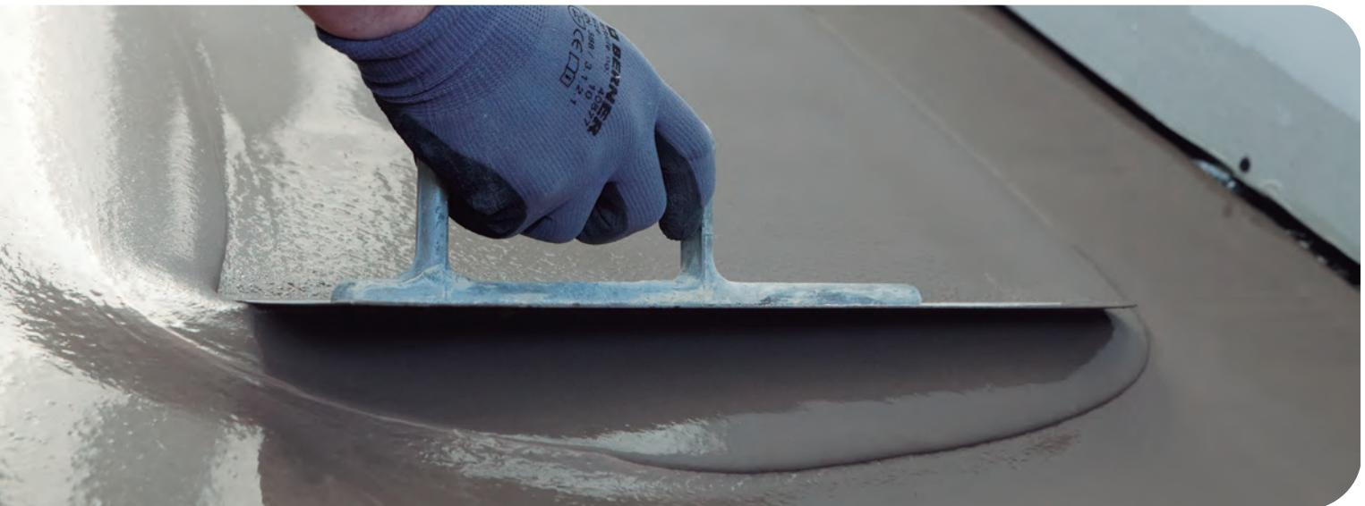
Dado que la colocación cerámica es en nuestro país, el revestimiento más utilizado, es necesario un tratamiento previo para poder colocar este tipo de revestimientos encima, utilizando imprimaciones aptas y morteros autonivelantes con una muy buena planimetría, priorizando siempre una renovación, con la menor cantidad posible de escombros.
