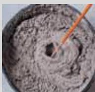
Amasar **weberep hormiestetic** con 3,75 – 4,25 litros de agua limpia por saco, según la consistencia que se quiera obtener. Para obtener un mortero tixotrópico de aplicación con llana, utilizar entrono a 3,75 litros. Para un mortero más fluido de aplicación con brocha, amasar con, aproximadamente, 4,25 litros.
