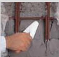
Aplicar **weberep hormiestetic** con llana, brocha o rodillo, en capas sucesivas de 1 mm de espesor. El material debe haber empezado a endurecerse antes de aplicar la siguiente capa.
