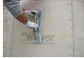
No aplicar nunca la malla directamente sobre el material aislante. En las juntas de la malla deberá existir una superposición mínima de 10 cm, y esta deberá envolver las aristas donde existan **webertherm perfil esquinero PVC**.
