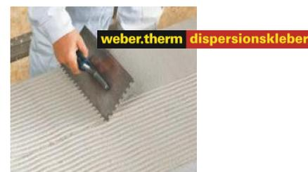
Sobre el soporte plano se aplicará el mortero de adhesión mediante la técnica del doble encolado aplicando el producto en toda la superficie de la placa y sobre el soporte, con una llana dentada (de dientes de 9-10 mm).
