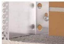
Colocar el perfil en el límite del sistema, y colocar la placa a testa posteriormente, encajándola en el mismo.
