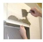
Embeber la malla en el mortero regularizador weber.therm base, o bien sobre los revestimientos minerales de acabado, weber.therm color o weber.therm clima.
