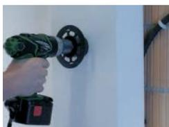
Limpiar la zona de los restos de material aislante desprendidos durante el proceso de fresado.
