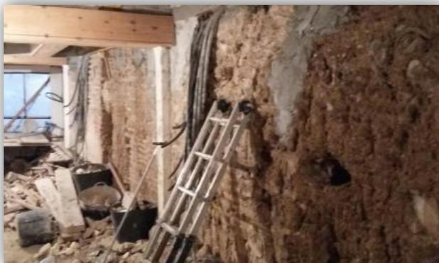
Una vez aplicado y seco el consolidante, se iniciará la aplicación del termo-enfoscado, **weber.therm** aisle hasta el espesor deseado, previamente al inicio de la aplicación se recomienda realizar maestras que servirán de guía para el control del espesor y la planimetría final.
