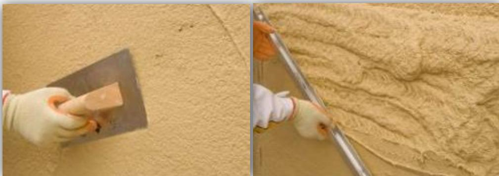
En el caso de acabado con un revestimiento mineral en capa gruesa, es necesario la colocación de **weber.therm malla 200** en la última capa del espesor, ver apartado 4.8.
