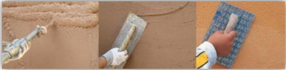
En las uniones del mortero de acabado con todo elemento rígido de la fachada, como puedan ser los marcos de puertas y ventanas, alféizares u otros salientes de la fachada, debemos asegurarnos que el mortero no quede solidario a ellos, para ello dejaremos una holgura que realizaremos con la herramienta adecuada cuando el mortero haya empezado a fraguar.
