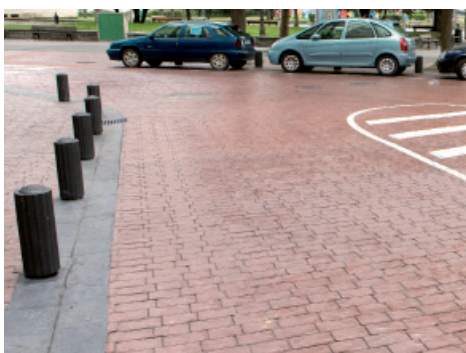
Renovación barrio de La Zorroza (acabado adoquín)
