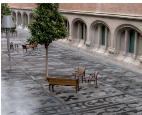
La Alhóndiga (acabado envejecido personalizado, realizado con manta)
