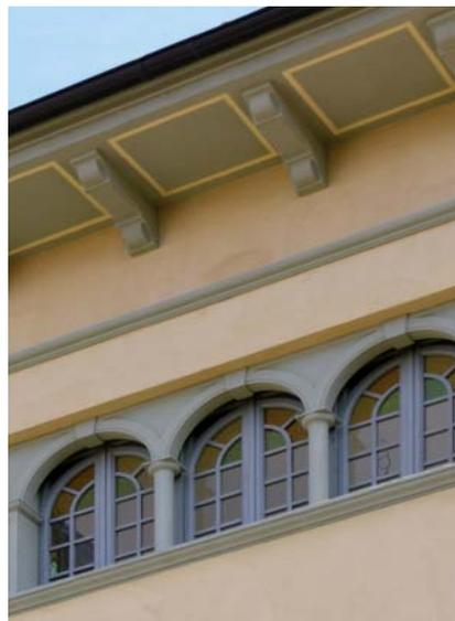
**Obra:** Rehabilitación de la Torre María (Siglo XX) para el área de medio ambiente Ayuntamiento de La Bisbal y CAP / **Localización:** Carretera de l'Aigüeta, nº 17. La Bisbal d'Empordà. Girona / **Superficie aplicada:** 450 m<sup>2</sup> / **Año finalización:** 2008 / **Sistema de revestimiento:** **weber.cal basic** y **weber.cal estuco** crema acabado liso
