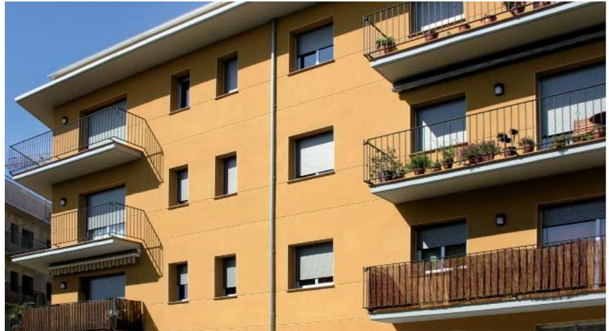
**Obra:** Rehabilitación de una casa / **Localización:** Pl. Major, nº 10. Viladrau / **Superficie aplicada:** 150 m<sup>2</sup> / **Año finalización:** 2009 / **Sistema de revestimiento:** **weber.pral eco** arcilla en acabado raspado. Zócalo en color índico, acabado a sillería con el interior raspado y plington liso
