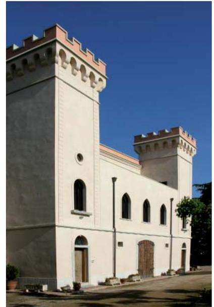
**Obra:** Rehabilitación bloque de viviendas en el casco antiguo de Reus / **Localización:** C/ Casals, nº 1. Reus.Tarragona / **Superficie aplicada:** 300 m<sup>2</sup> / **Año finalización:** 2009 / **Sistema de revestimiento:** **weber.pral eco** marfil acabado raspado y con una sillería marcada con junquillos. En las esquinas se ha hecho una sillería en relieve con el color argón y acabado texturado
