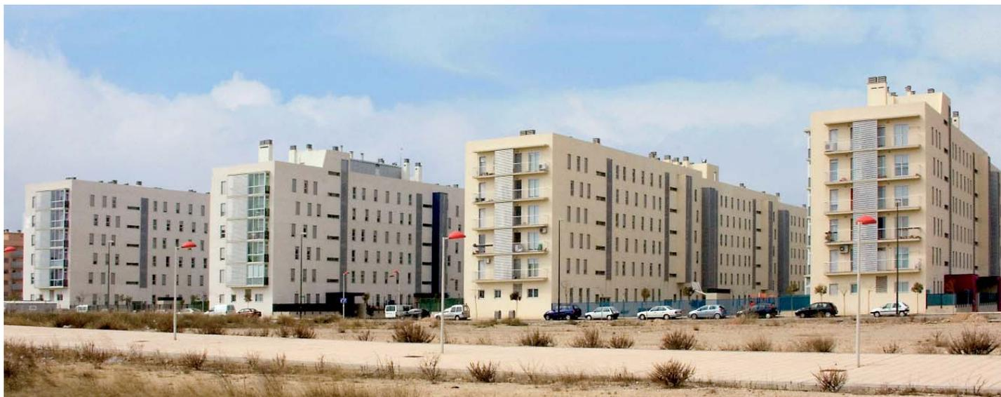
**Obra:** 2 bloques de viviendas / **Localización:** C/ Los puentes de Madison / **Superficie aplicada:** 16.000 m<sup>2</sup> / **Año finalización:** 2005-2006 / **Sistema de revestimiento:** sistema **weber.therm mineral** revestido con **weber.therm clima** blanco/beige, acabado raspado
