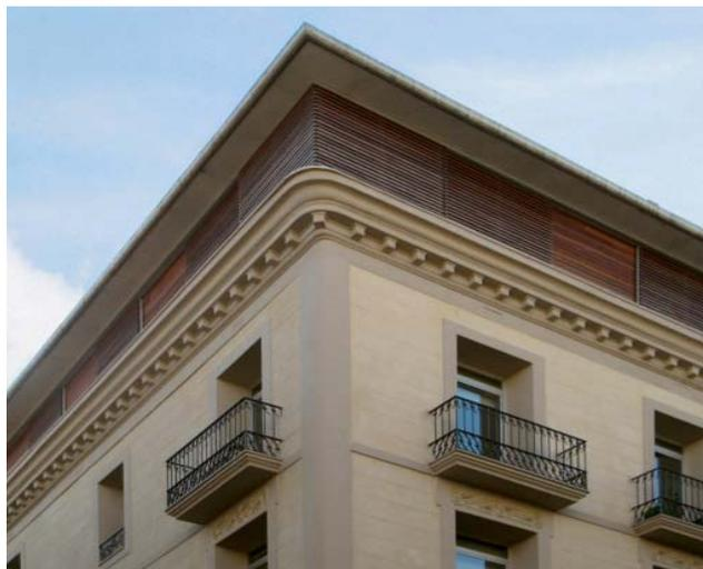
**Obra:** Rehabilitación edificio de viviendas / **Localización:** Raval de Robuster, 28. Reus. Tarragona / **Superficie aplicada:** 550 m<sup>2</sup> / **Año finalización:** 2009 / **Sistema de revestimiento:** **weber.pral eco** beige, acabado fratasado con enmarcados y esgrafiados en acabado liso
