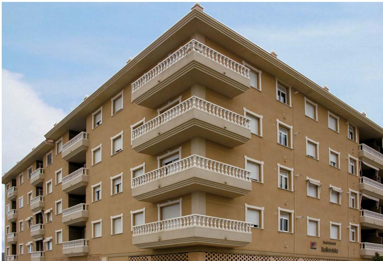
**Obra:** Edificio de viviendas / **Localización:** C/ Piñeres 14-16 Candás. Asturias / **Superficie aplicada:** 1.200 m<sup>2</sup> / **Año finalización:** 2008 / **Sistema de revestimiento:** **weber.pral eco** jade y musgo, acabado raspado
