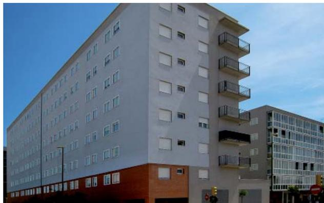
**Obra:** 3 bloques de viviendas dispuestos en forma de "U" / **Localización:** C/ Paseo de los Olvidados. Zaragoza / **Superficie aplicada:** 8.000 m<sup>2</sup> / **Año finalización:** 2006 / **Sistema de revestimiento:** sistema **weber.therm mineral** revestido con **weber.therm clima** azul y gris, acabado raspado
