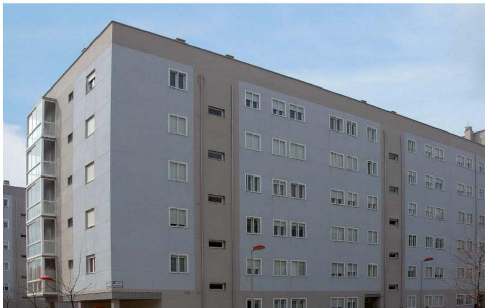
**Obra:** 3 bloques de viviendas dispuestos en forma de “U” / **Localización:** C/ Todo sobre mi madre. Zaragoza / **Superficie aplicada:** 8.500 m<sup>2</sup> / **Año finalización:** 2006 / **Sistema de revestimiento:** sistema **weber.therm mineral** revestido con **weber.therm clima** blanco y gris, acabado raspado
