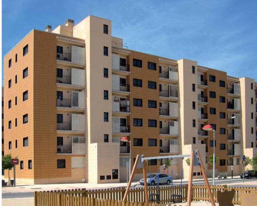
**Obra:** 3 bloques de viviendas / **Localización:** C/ Cantando bajo la lluvia / **Superficie aplicada:** 3.000 m<sup>2</sup> / **Año finalización:** 2007 / **Sistema de revestimiento:** sistema **weber.therm mineral** revestido con **weber.therm clima** crema, acabado raspado
