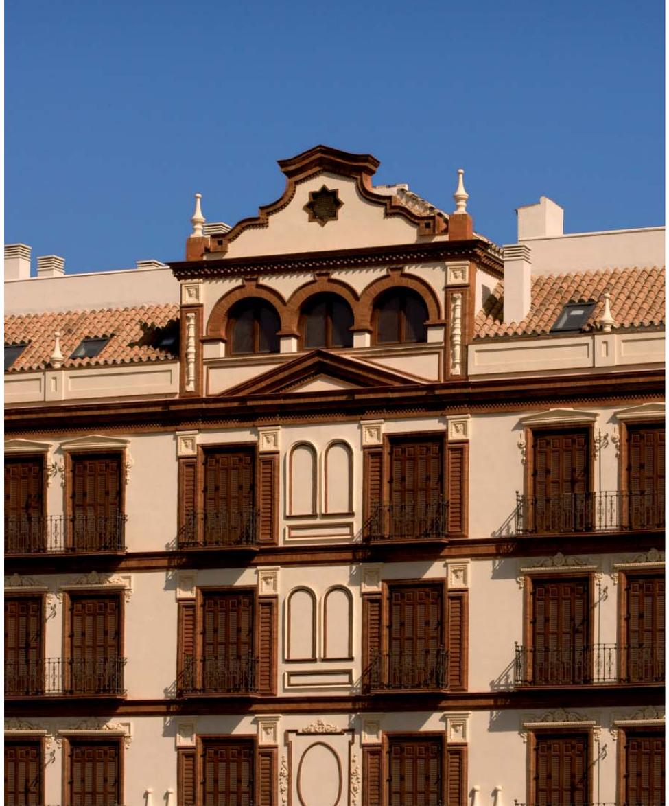
**Obra:** Rehabilitación y reforma de un edificio para viviendas y oficinas / **Localización:** Av. Rosaleda. Málaga / **Superficie aplicada:** 800 m<sup>2</sup> / **Año finalización:** 2008 / **Sistema de revestimiento:** **weber.cal revoco** marfil, acabados fratasado y liso; **weberTXT** reproduciendo ladrillos en los elementos decorativos de la fachada
