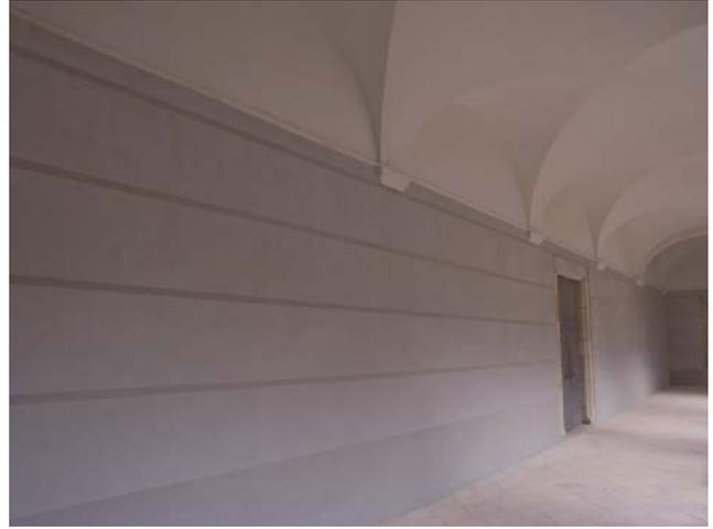
**Obra:** Rehabilitación integral de un edificio situado en el Casco histórico de Girona / **Localización:** C/ Pujada Mercè, nº12. Girona / **Superficie aplicada:** 400 m<sup>2</sup> / **Año finalización:** 2009 / **Sistema de revestimiento:** weber.pral eco amarillo acabado en sillería en rombo, con plintón liso y el interior raspado. Porche y parte baja revestido con el color especial 784 en acabado liso con despieces horizontales en acabado raspado o marcados con un llaguero
