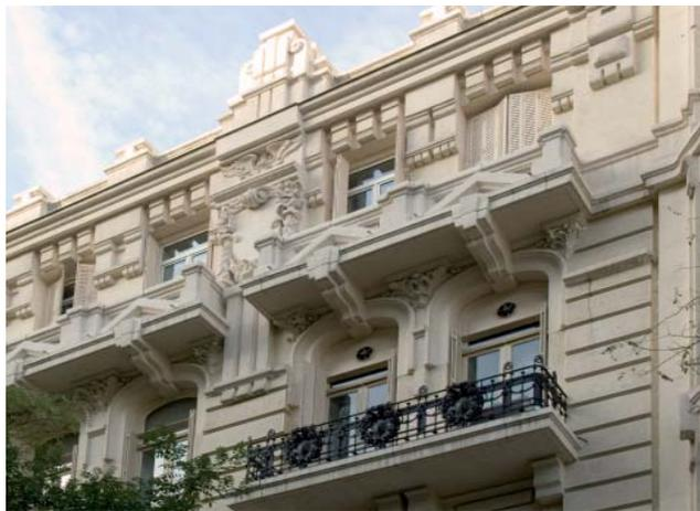
**Obra:** Rehabilitación de bloque de viviendas / **Localización:** Paseo del Prado, 12. Madrid / **Superficie aplicada:** 450 m<sup>2</sup> / **Año finalización:** 2009 / **Sistema de revestimiento:** **weber.cal revoco** marfil acabado con sillería a martillina con plington liso
