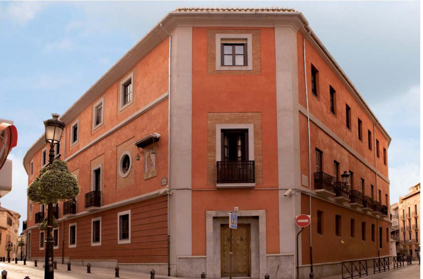
**Obra:** Rehabilitación de un bloque de viviendas / **Localización:** Plaza de la Lealtad, 2. Madrid / **Superficie aplicada:** 800 m<sup>2</sup> / **Año finalización:** 2009 / **Sistema de revestimiento:** **weber.cal revoco** beige. Acabado de sillería con plington liso y martillina; y sillería de esquina acabada a pico de gavián
