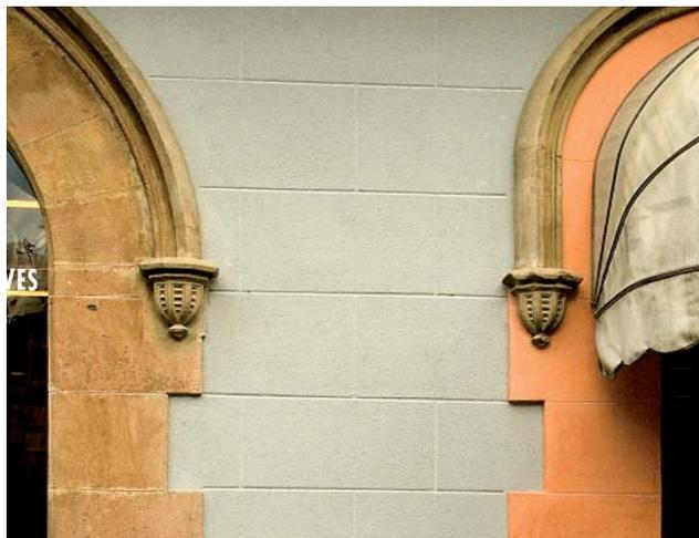
**Obra:** Rehabilitación de bloque de viviendas / **Localización:** Plaza Mayor, 13. Viladrau. Girona / **Superficie aplicada:** 150 m<sup>2</sup> / **Año finalización:** 2009 / **Sistema de revestimiento:** **weber.pral eco** gris acabado raspado y **weber.cal estuco** salmón acabado liso
