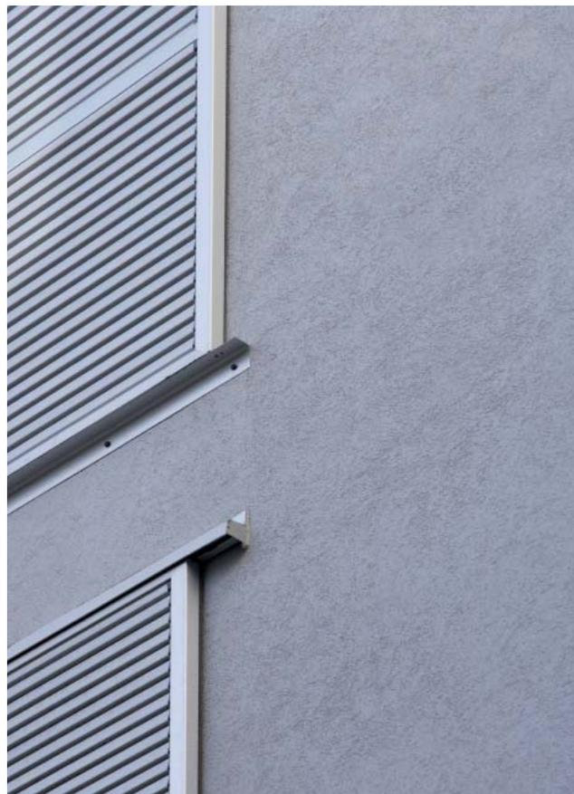
**Obra:** Edificio de viviendas / **Localización:** C/ Pozo 3. La Coruña / **Superficie aplicada:** 300 m<sup>2</sup> / **Año finalización:** 2009 / **Sistema de revestimiento:** sistema **weber.therm etics** revestido con **weber.tene** plata y acabado fratasado
