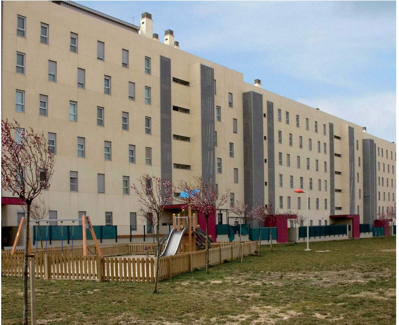
**Obra:** 2 bloques de viviendas / **Localización:** C/ Los puentes de Madison / **Superficie aplicada:** 16.000 m<sup>2</sup> / **Año finalización:** 2005-2006 / **Sistema de revestimiento:** sistema **weber.therm mineral** revestido con **weber.therm clima** blanco/beige, acabado raspado
