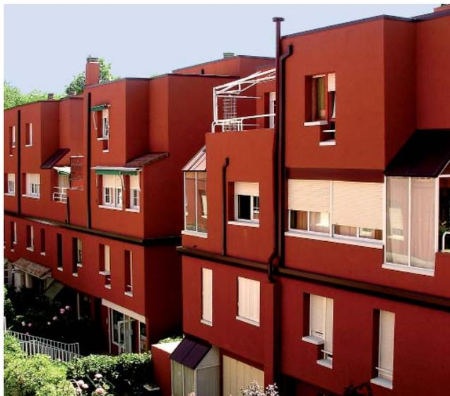
El mortero polimérico de fijación y regularización de las placas de aislamiento presta una excelente adherencia a los muros, que presentaban múltiples imperfecciones y falta de planeidad, además de incorporar en su composición cargas minerales, resinas y fibras, lo que le confiere una baja retracción y altas prestaciones a flexión y compresión, garantizando la estabilidad del conjunto.
