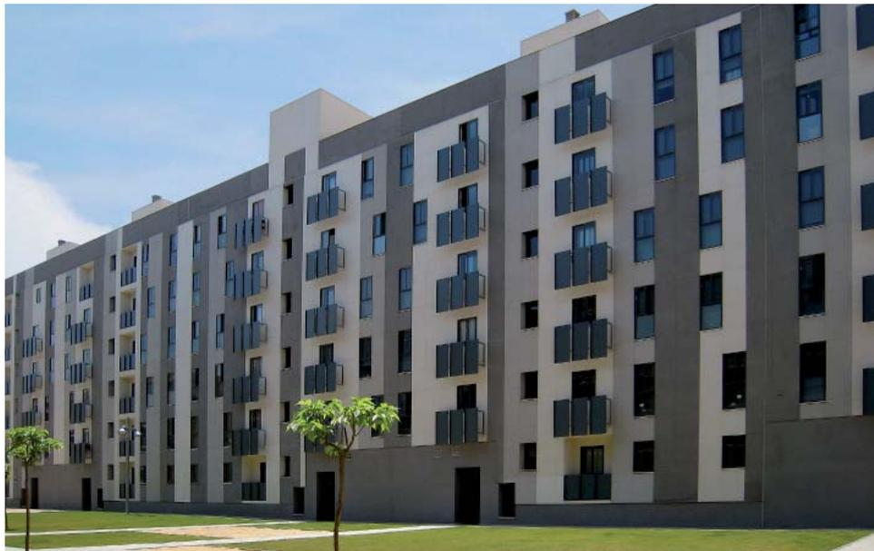
**Obra:** 3 bloques de viviendas dispuestos en forma de "U" / **Localización:** C/ Luces de la Ciudad, Zaragoza / **Superficie aplicada:** 6.500 m<sup>2</sup> / **Año finalización:** 2007 / **Sistema de revestimiento:** sistema **weber.therm mineral** revestido con **weber.therm clima** blanco, acabado raspado
