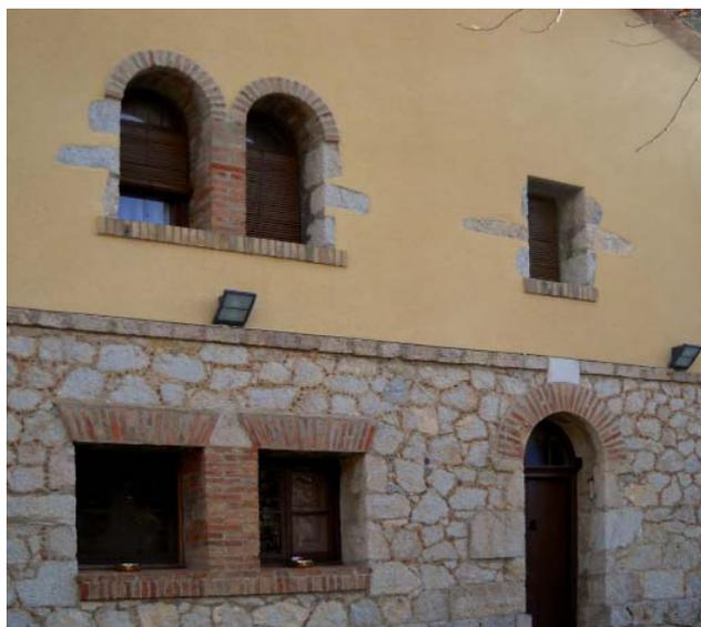
**Obra:** Rehabilitación de la Fonda Casanova / **Localización:** Cambrils dels Pirineus, Lleida / **Superficie aplicada:** 400 m<sup>2</sup> / **Año finalización:** 2009 / **Sistema de revestimiento:** sistema **weber.therm mineral** revestido con **weber.therm clima** arena acabado raspado
