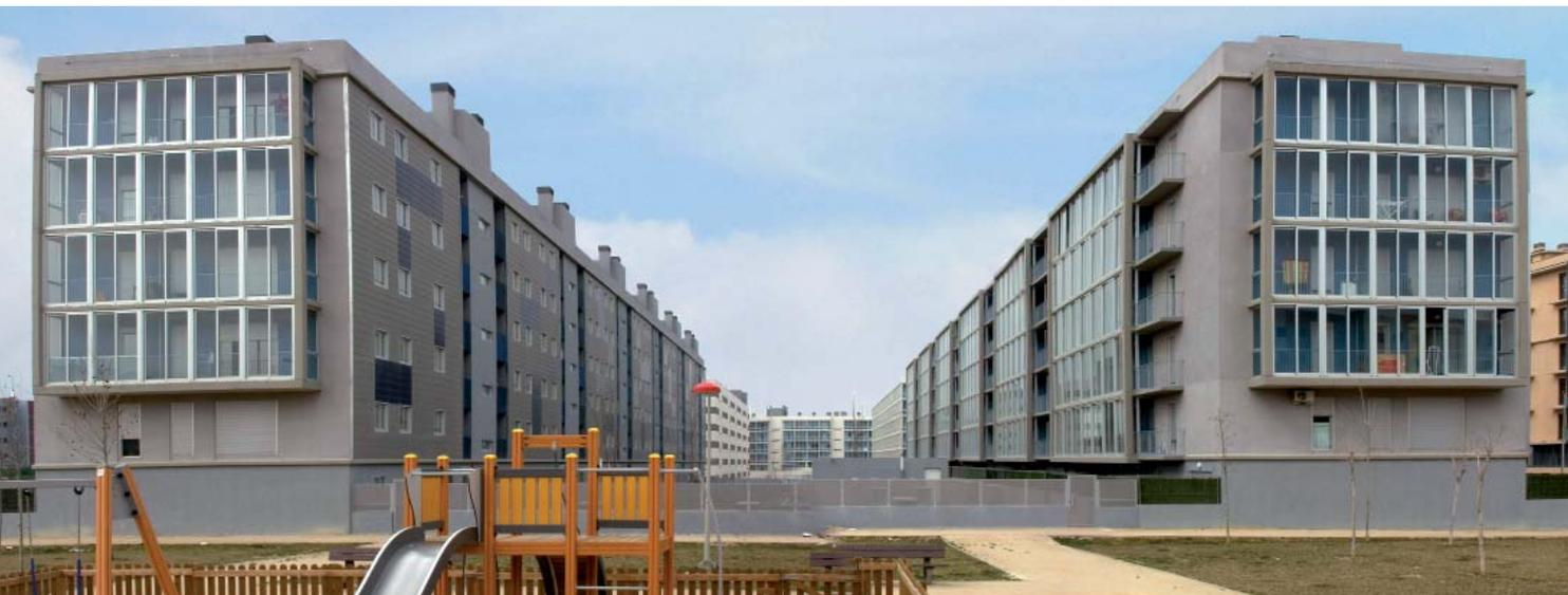
**Obra:** 2 bloques de viviendas / **Localización:** C/Al este del Edén. Zaragoza / **Superficie aplicada:** 9.000 m<sup>2</sup> / **Año finalización:** 2007 / **Sistema de revestimiento:** sistema **weber.therm mineral** revestido con **weber.therm clima** gris acabado raspado
