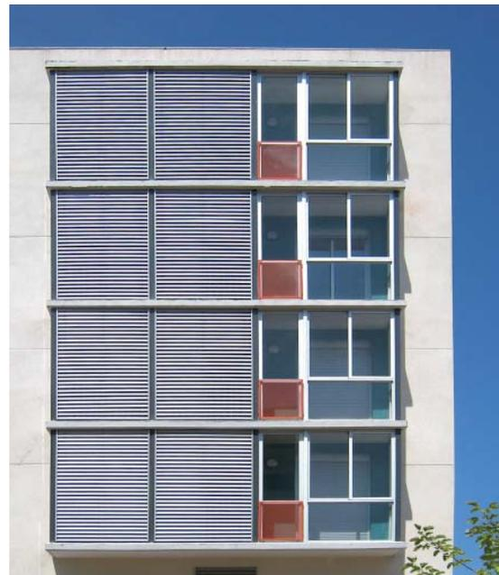
**Obra:** 2 bloques de viviendas / **Localización:** C/ Al este del Edén. Zaragoza / **Superficie aplicada:** 8.000 m<sup>2</sup> / **Año finalización:** 2007 / **Sistema de revestimiento:** sistema **weber.therm mineral** revestido con **weber.therm clima** blanco, acabado raspado
