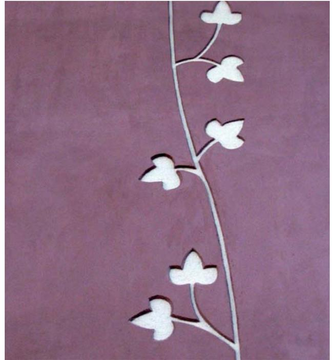
**Obra:** Bloque de viviendas / **Localización:** C/ del Pont 42, Torelló, Barcelona / **Superficie aplicada:** 120 m<sup>2</sup> / **Año finalización:** 2009 / **Sistema de revestimiento:** **weber.pral eco** travertino en acabado raspado y cuero en acabado liso. Motivo decorativo floral diseñado por la dirección facultativa, esgrafiado con dos colores, travertino (debajo) y cuero en acabado liso
