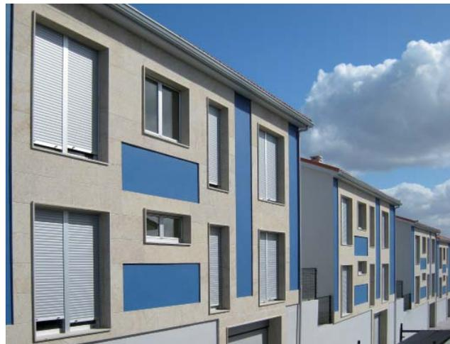
**Obra:** Bloques de viviendas / **Localización:** Finisterre. La Coruña / **Superficie aplicada:** 500 m<sup>2</sup> / **Año finalización:** 2009 / **Sistema de revestimiento:** **weber.tene** marino acabado fratasado
