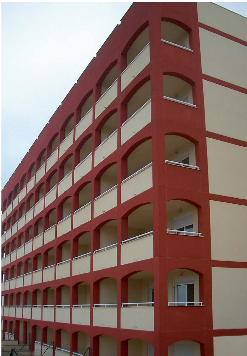
weber.pral acabado raspado colores blanco y teja Urbanización Torresol Murcia
