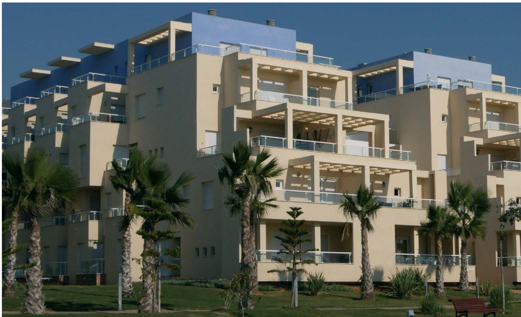
weber.pral acabado raspado colores turquesa y especial nº 29 Edificio Almerimar - Alboran Almería
