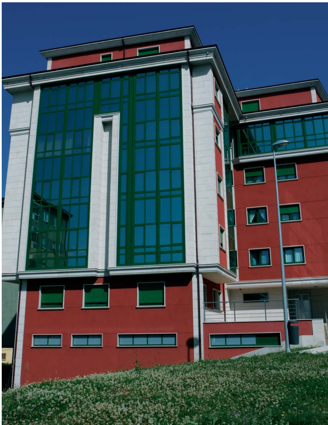
weber.pral acabado raspado colores teja y blanco Calle Inés de Castro 1 Lugo
