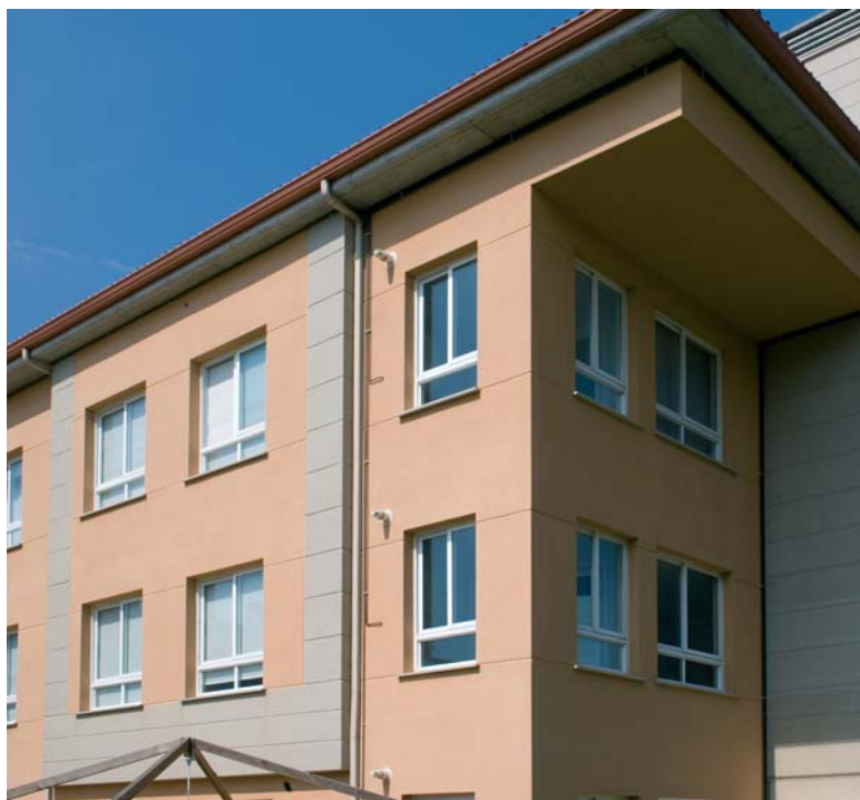
weber.pral acabado raspado color gamuza Calle Antonio de Sucre 5 a 25 Urbanización As Gavias Bastiaqueiro Oleiros Coruña
